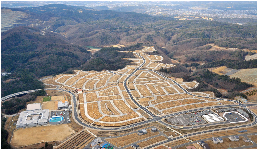
箕面第2区域開発工事
